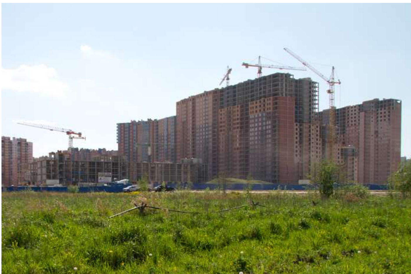
Вид с Областной улицы на секции 35-26, 15-17 со двора
