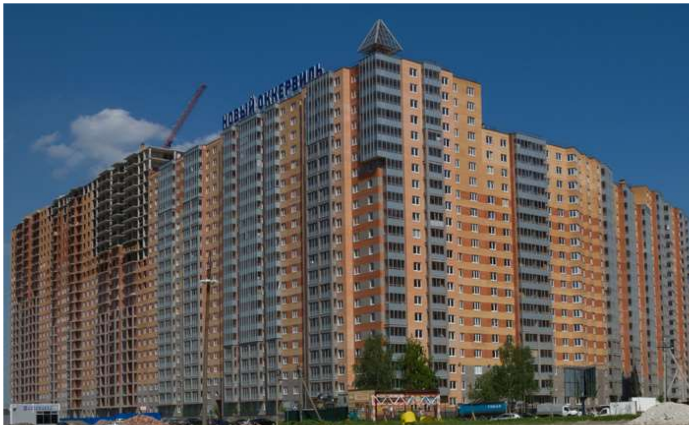
Вид с Областной улицы на секции (слева направо) 17-7
